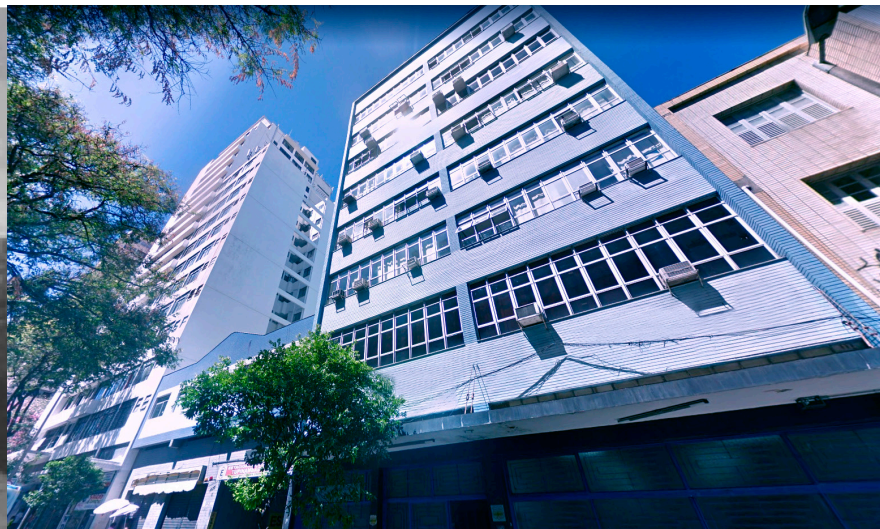
Sede atual do SECBHRM - Rua dos Tupinambás, 1045, Centro de BH
